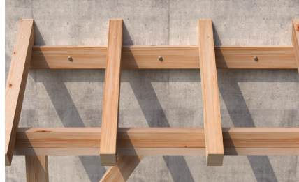
Balkconstructie voor een afdak
