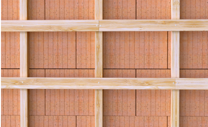
Houten achterconstructies t.b.v. gevels
