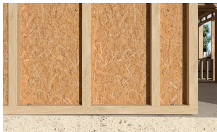
Stellen van ringbalken
